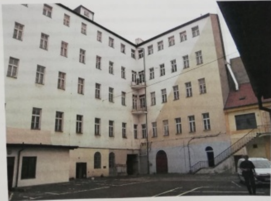
6. Dvorní průčelí hlavní budovy – pohled východním směrem.
